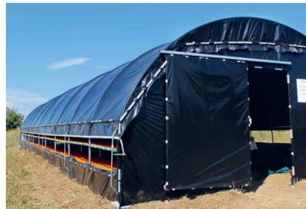
Otvori u ovoj tunelskoj sušari ne dopuštaju optimalan protok vazduha. Ulazi za vazduh na dnu postavljeni su previsoko, a izlaz na vrhu tunela nedostaje. U tom slučaju vazduh ne struji kroz police i materijal za sušenje i ne može izvesti vlažan vazduh kroz vrh.
